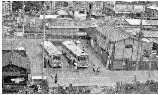
写真②【久米川駅南口(整備前)】
